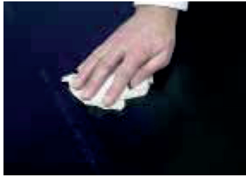
Voorbehandeling achterzijde steni® met Easy Prep Wipes.
